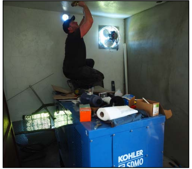
Generator mit Entlüftung
